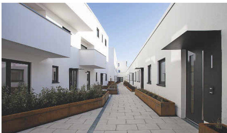
Die neue Wohnanlage mit Innenhof liegt über dem Parkhaus mit Blick über Köln.
