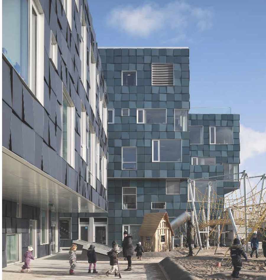
Die türkis-blau schimmernde Solarfassade mit 12 000 PV-Modulen macht den Neubau zu einem der größten gebäudeintegrierten Solarkraftwerke Dänemarks.
