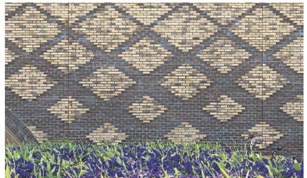
Ornamentale Rautenstruktur: durch dunkelbraune und vorstehend gemauerte hellbraune Handformziegel.
