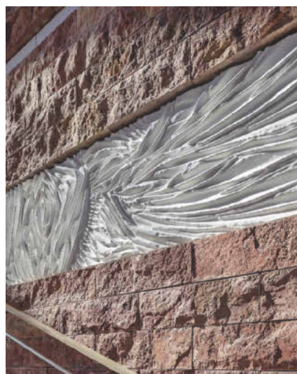
Zwischen rotem Travertin wurde weißer Beton an der Oberfläche gefaltet - mit der Assoziation der entwerfenden Modedesignerin an Kleiderfalten.
