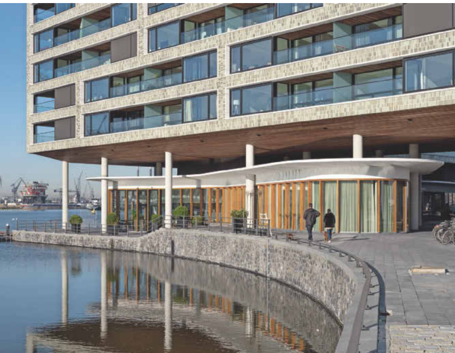
Unter der aufgeständerten Basis befinden sich organisch geschwungene Pavillons mit Glasfassaden als attraktive Ladenlokale.
