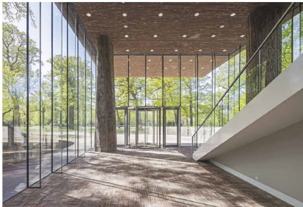
Im Foyer sorgen neben raumhoher Verglasung auch baumartig nach oben sich verjüngende Stahlbetonstützen sowie die von außen fortgeführte Pflasterung für nahtlosen Übergang zum Außenraum.
