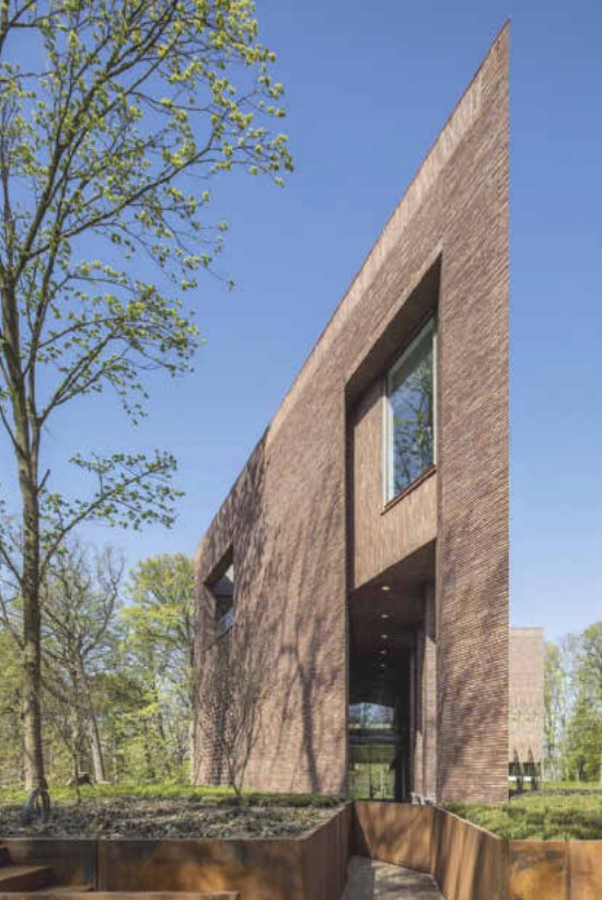
Zugespitzter Backsteinbau mit handgefertigtem rötlich-braunem Stein in extrem schlankem „Lang-Dünformat“.
