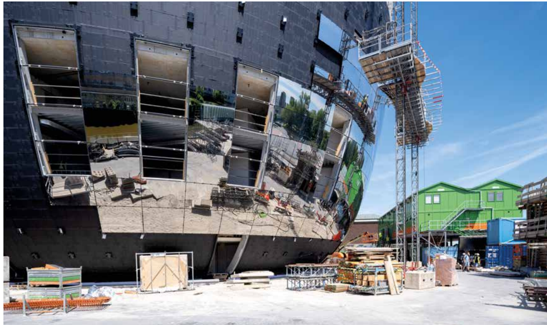
Errichtung der Spiegelfassade. Die horizontalen und vertikalen Fugen zwischen den Resol-Hartschaumplatten unter den Spiegelementen wurden mit dem HARDCAST® FSR40-Butylband von CARLISLE® abgedichtet.
