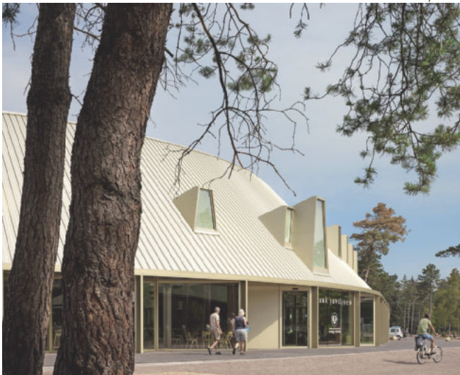
Die großflächige Dachkonstruktion besteht aus hellen Aluminiumprofiltafeln und wird filigran gegliedert durch Gauben.
