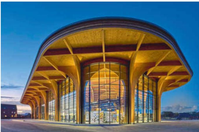
Die Konstruktion wird getragen von 22 Kreuzstützen, nach oben aufgehend als geschwungene Träger im Dachtragwerk.
