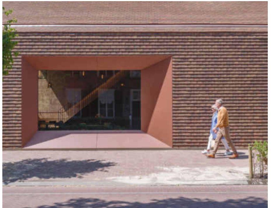
Terrakottaziegel hüllen das neue Museum erdig-warm ein, angelehnt an Van Goghs Vorliebe für einfaches Leben.
