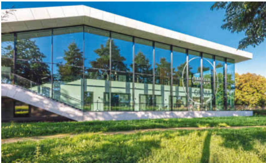
Die Fassade wurde als Aluminium-Pfosten-Riegel-Konstruktion mit Dreifach-Sonnenschutzglas umgesetzt. Die sehr hohe Lichttransmission der Verglasung unterstützt eine helle, freundliche Atmosphäre.
