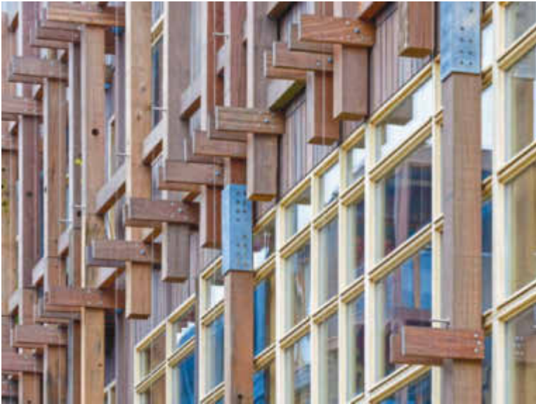
Die nach außen hin sichtbare Tragkonstruktion aus Holz soll in den kommenden Jahren als Rankhilfe für eine Schatten spendende Fassadenbegrünung dienen.
